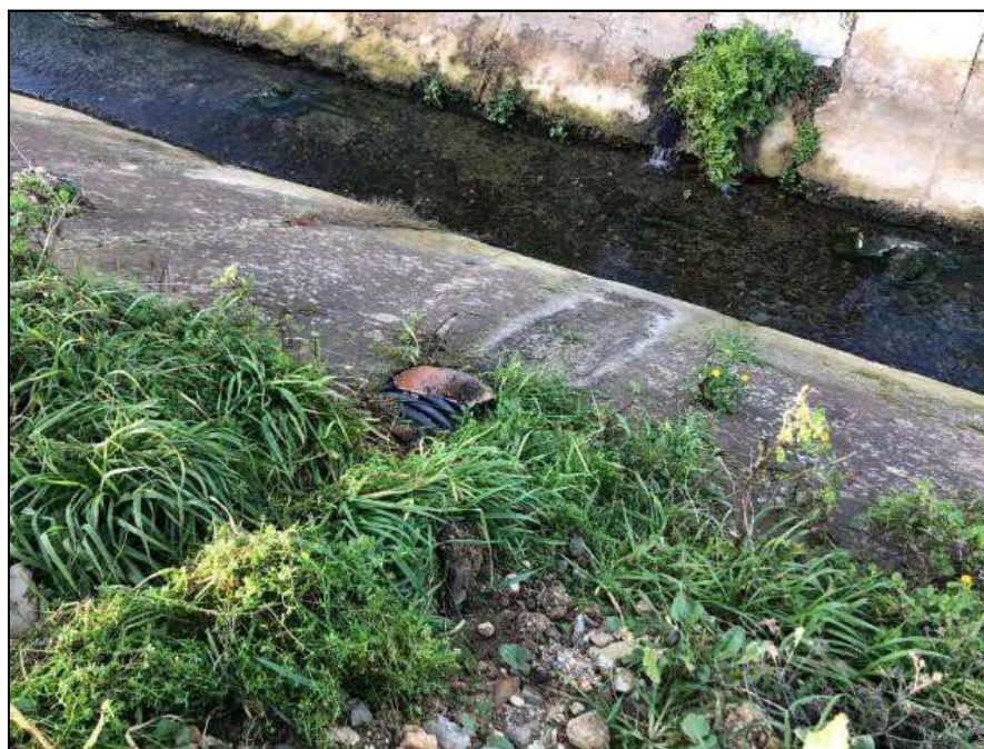
Figura 4.4/VIII: Scarico acque meteoriche nel canale di guardia
