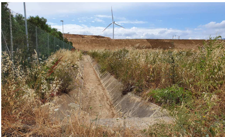
Figura 5.5/XIX: Canale di raccolta e drenaggio superficiale delle acque sul lato est del lotto a ridosso del canile
